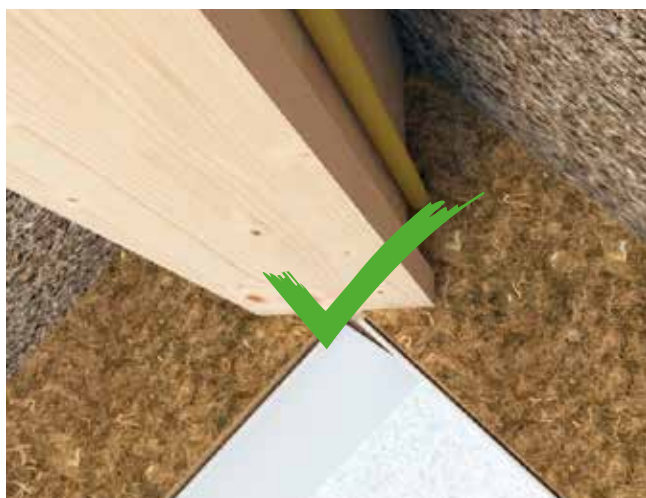
Nok volledig vullen met Isovlas
